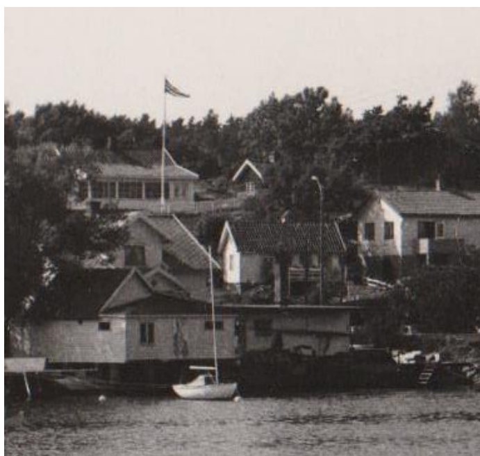
Her kommer bryggerhuset godt fram midt i bildet. Det er tatt før rivingen i siste halvdel av 1970-tallet.
