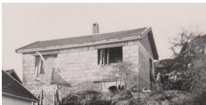
Huset til Ellen og Konrad under bygging.
